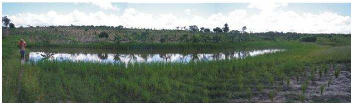
Figura 3. Barragem subterrânea construída seguindo o modelo Asa Brasil com acumulação superficial de água. Assentamento Santo Agostinho- Caraúbas/RN.
