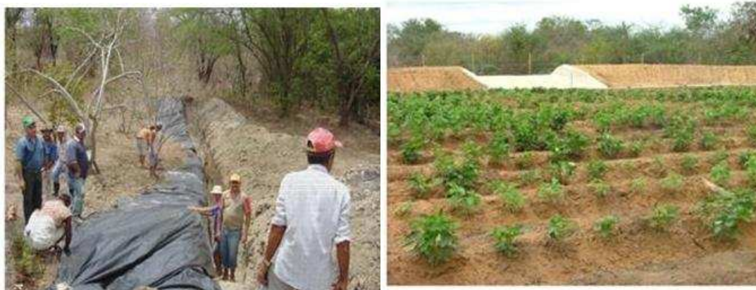
Figura 4. Barragem subterrânea submersível, modelo EMBRAPA, com cordões de contorno na bacia hidráulica.
