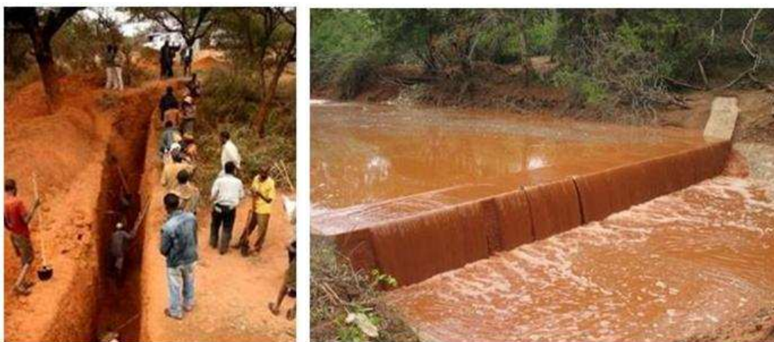
Figura 2. Processo de escavação manual e funcionamento de barragem subterrânea no Kênia, África. Fonte: Rain (2008).
