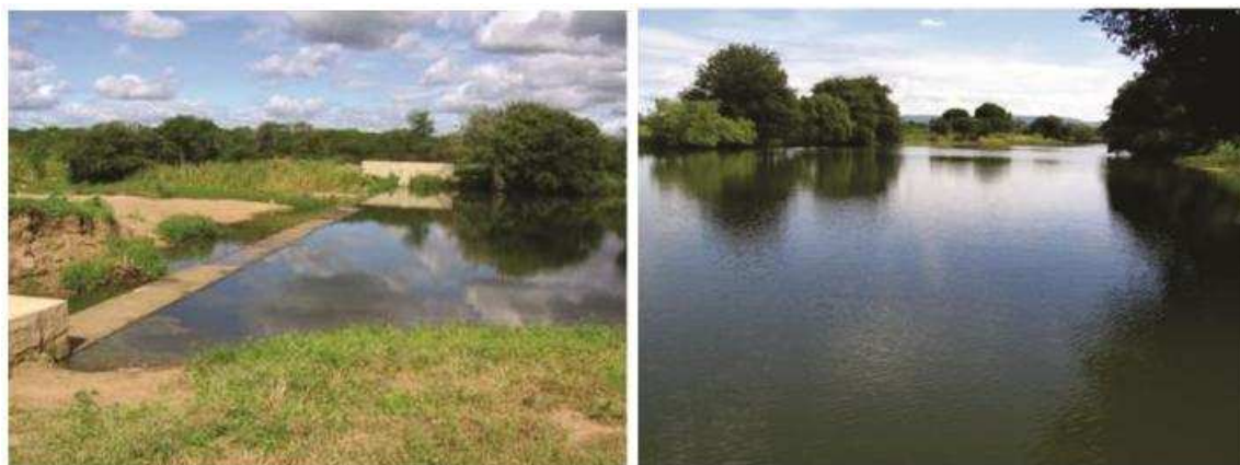
Figura 5. Barragem subterrânea submersível sucessiva modelo Serra Negra construída no leito do rio Umari, Umarizal, RN. (Foto: Alexandre de Oliveira Lima).
