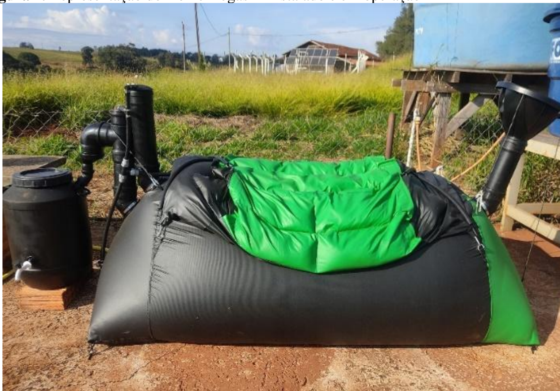
Figura 2. Representação do HomeBiogas™ instalado e em operação 1
