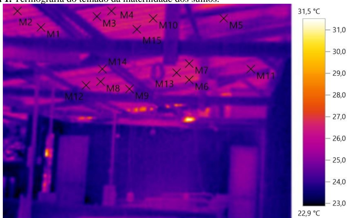
Figura 1. Termografia do telhado da maternidade dos suínos.
