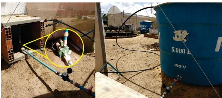
O volume de biogás gerado foi aferido por um medidor de gás do tipo diafragma, com contador de oito dígitos, tomada de pressão frontal, pressão máxima de trabalho de 50 KPa, vazão máxima de 4,5 m<sup>3</sup>h<sup>-1</sup> e vazão mínima de 0,0025 m<sup>3</sup>h<sup>-1</sup>.
