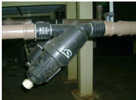
Figura 1. Filtro de disco de 120 mesh/Amiad, utilizado no sistema de irrigação do ensaio.
