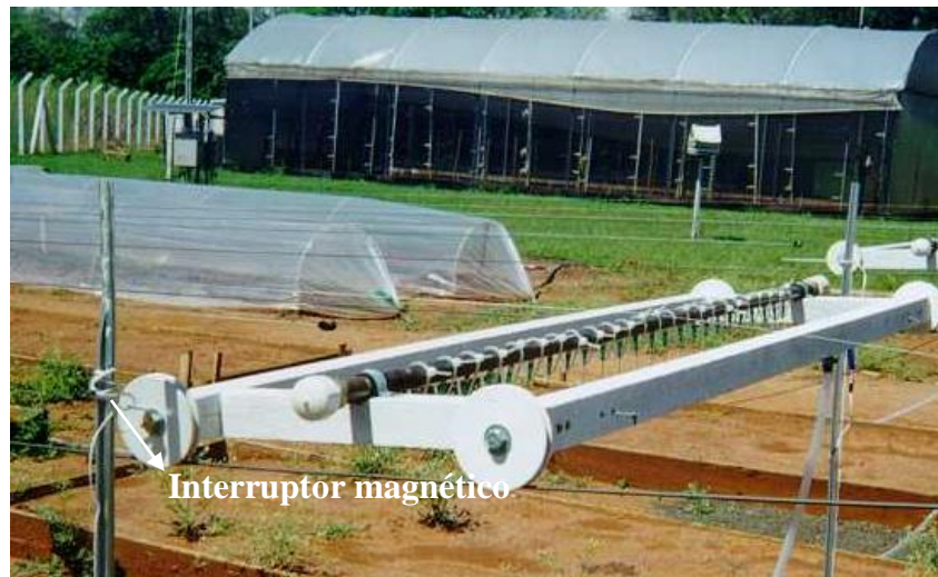
Figura 12. Interruptor magnético instalado na extremidade do canteiro.
