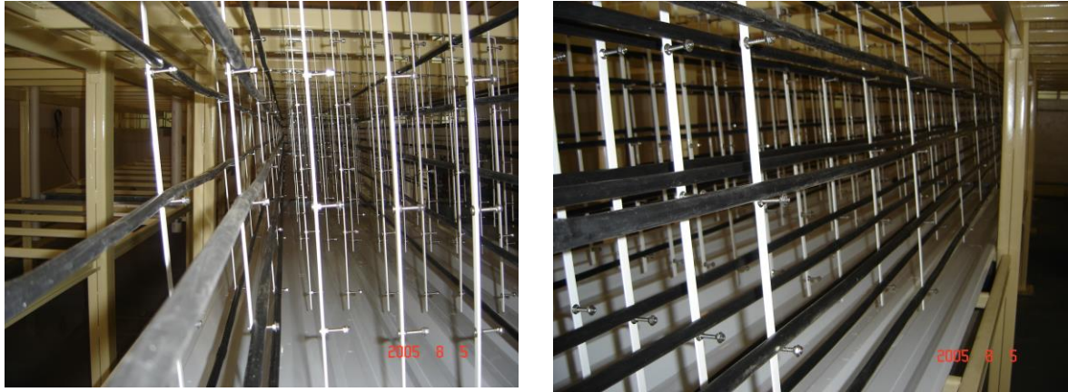
Figura 3. Detalhamento do desalinhamento das linhas gotejadoras na bancada
