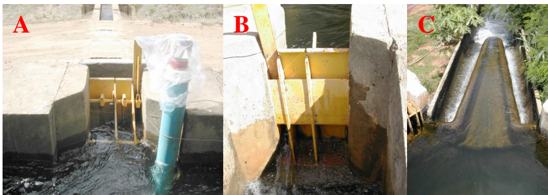
Figura 1. Comporta tipo módulo de máscara, modelo \text{XX}_1 , indicando a entrada (A) e saída de água (B) e estrutura hidráulica tipo “bico de pato” (C), no projeto Gorutuba. Nova Porteirinha, MG, 2005.
