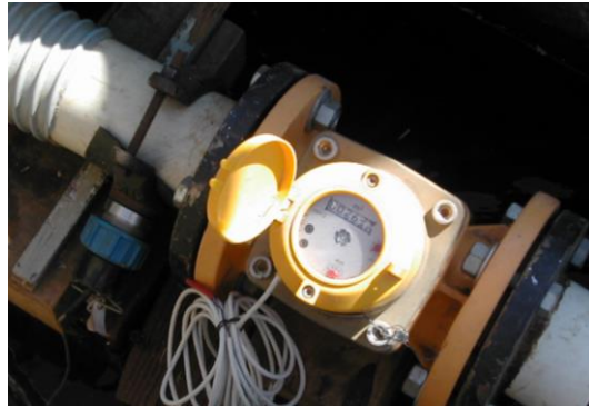
Figura 3. Hidrômetro com turbina tangencial instalado a jusante do sensor eletrônico de vazão.
