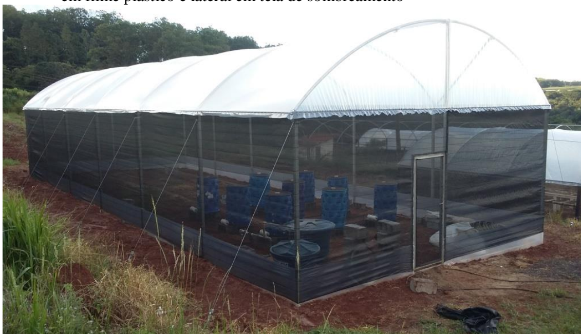
Figura 1. Vista frontal da casa de vegetação utilizada no experimento destacando a cobertura em filme plástico e lateral em tela de sombreamento
