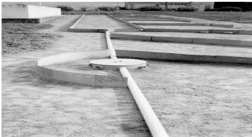
Figura 1 - Vista geral da estrutura de campo utilizada no balanço hídrico.
