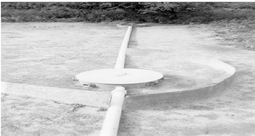
Figura 3. - Detalhe do coletor de escoamento superficial.
