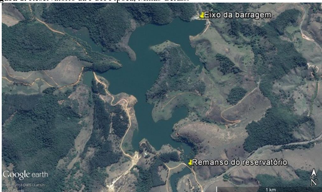
Figura 1. Reservatório da PCH Pipoca, Minas Gerais.
