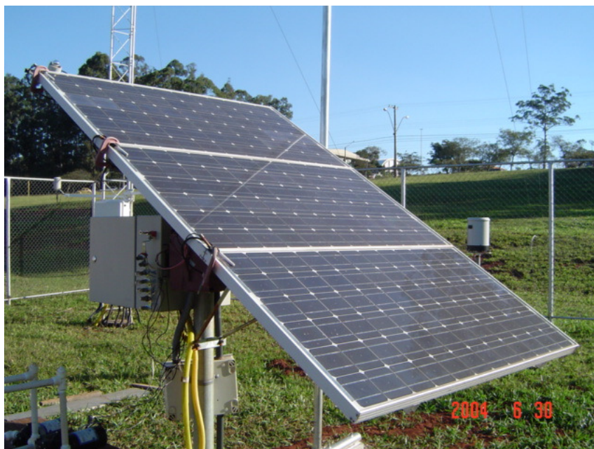
Figura 2 - Módulos fotovoltaicos de 100 Wp cada, instalados em paralelo e constituindo o painel fotovoltaico.
