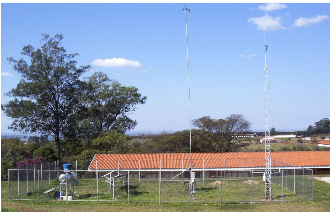
Figura 1 - Vista panorâmica do NEAR e da instalação do sistema híbrido eólico fotovoltaico.
